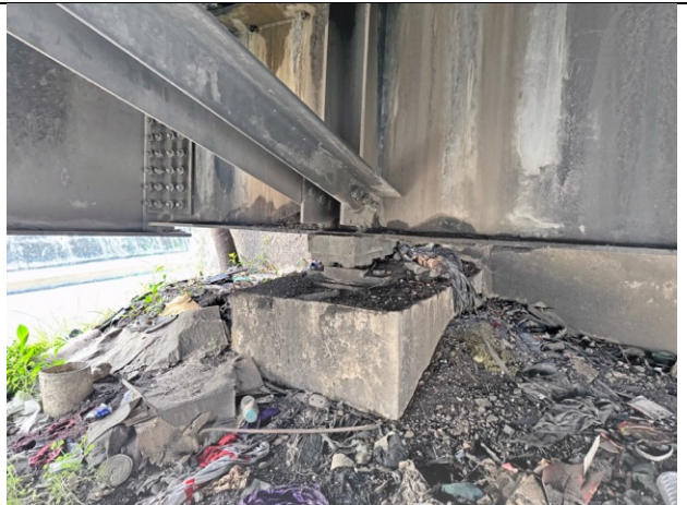
Apoyo de sección 8 en el estribo sur.
